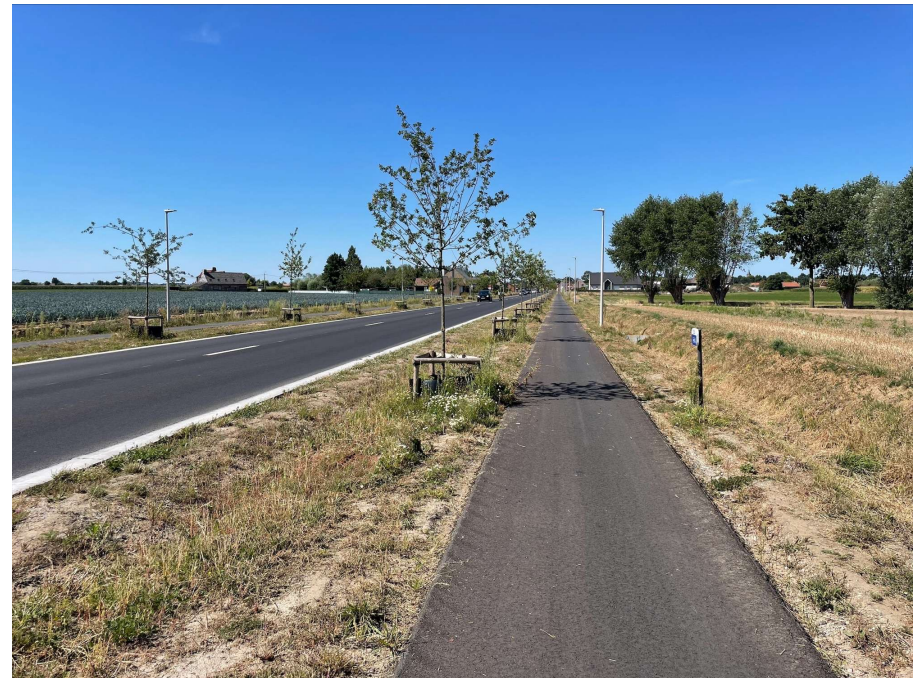
Fietspad in asfalt
