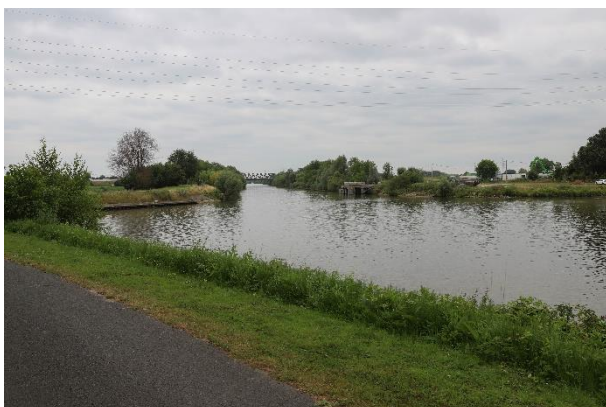
Afb. 23: samenloop tussen het Afleidingskanaal van de Leie en de oude Leiearm. In de toekomst wordt een fietsersbrug voorzien t.h.v. dit punt
