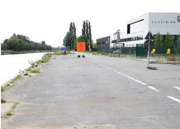
figuur 12 bestaande kade aan het bedrijventerrein Dossche (Google Street View) bron Google Street View
