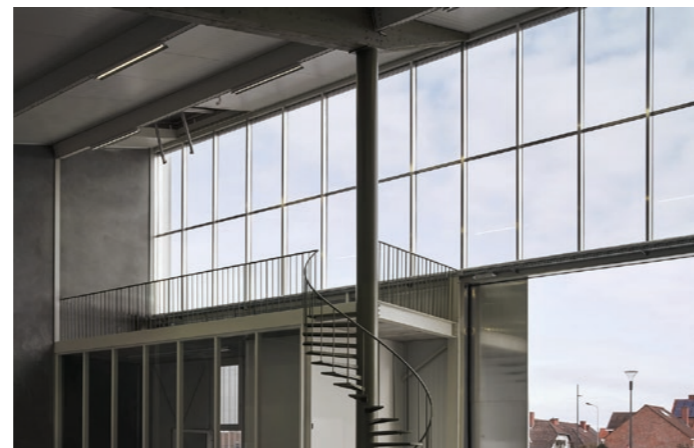
Een voorbeeld van een gordijngewelsysteem (OFFICE kgdvs - Incubator Kortrijk)
