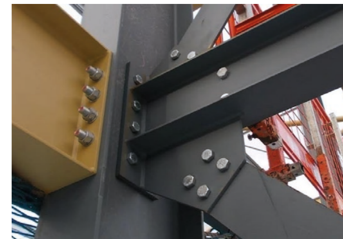
Circulaire staal-bouw details met moeren
