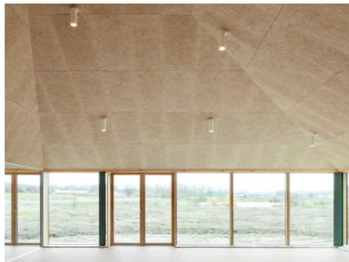
Het gebruik van houtwol platen voor akoestische performantie. (Claus Pryds Arkitekter)
