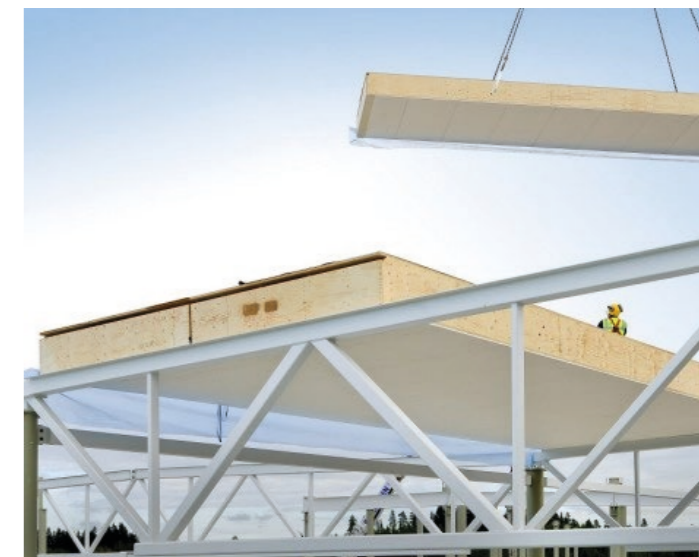
Staalstructuur met houten geprefabriceerde secundaire structuur.
