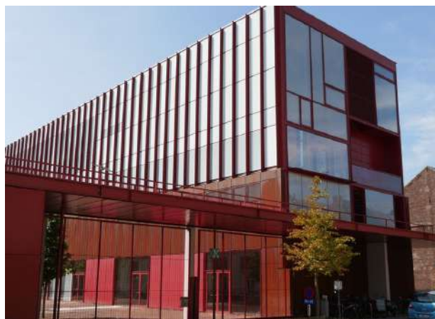
figuur 42 KADE, geïntegreerd in het stadscentrum (bron: stad Deinze)
