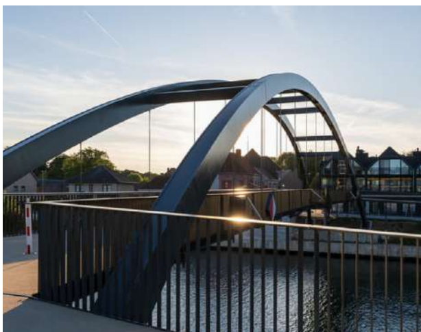
figuur 9 Lovellingbrug over Kanaal van Schipdonk in Nevele (bron: Travel For Motion)
