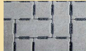
Opritten in waterdoorlatende klinkers
