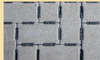
Opritten in waterdoorlatende klinkers
