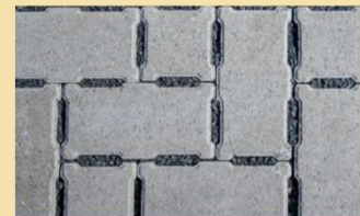
Opritten in waterdoorlatende klinkers
