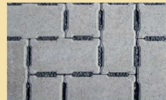
Opritten in waterdoorlatende klinkers
