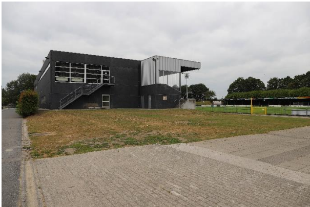
Afb. 37: huidige gebouwen van het stadion
