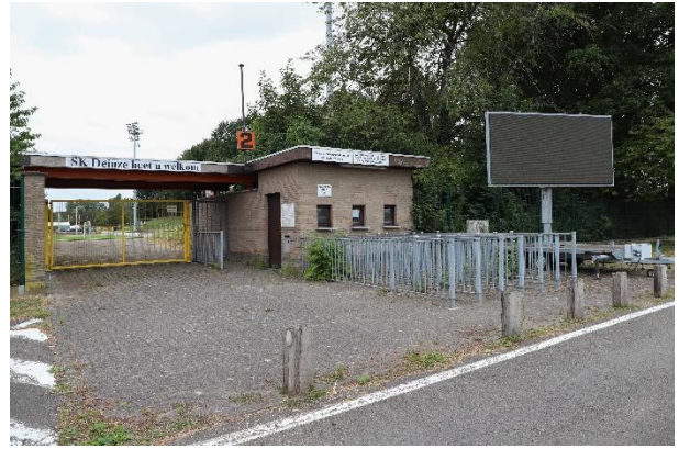
Afb. 30: gescheiden toegang tot het stadion
