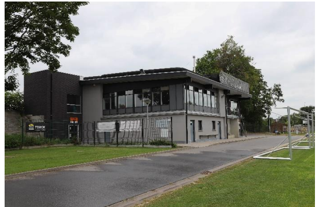
Afb. 38: huidige gebouwen van het stadion
