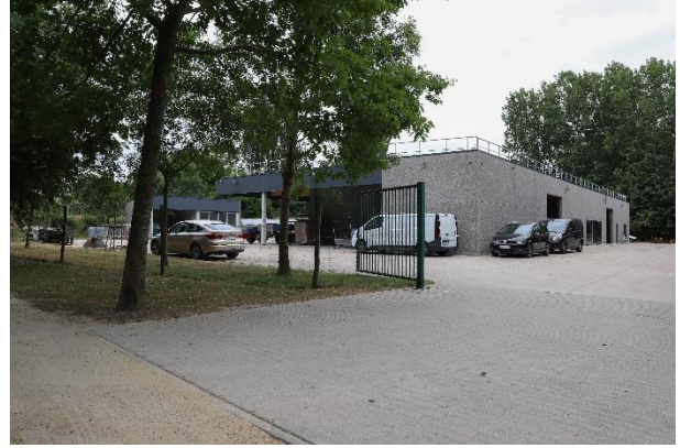
Afb. 36: de loods waar materiaal wordt in opgeslagen
