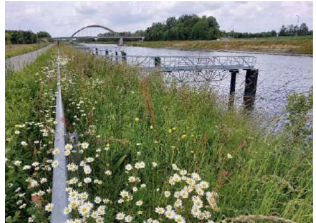
figuur 30 kanaal van Schipdonk ter hoogte van Meigem (bron: Vlaamse Waterweg)
