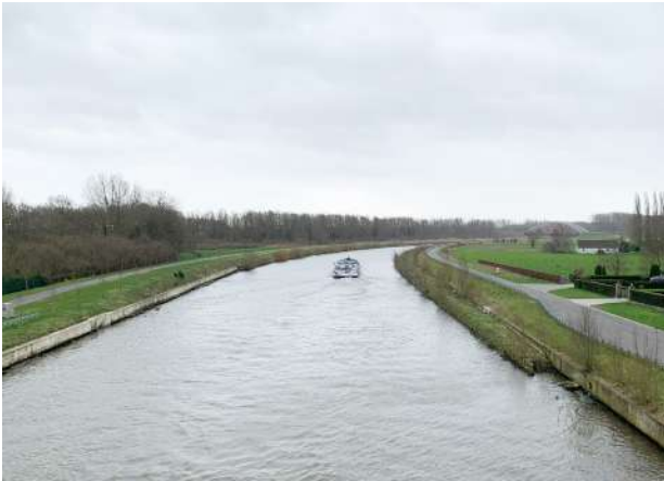
figuur 56 kanaal ter hoogte van Merendree
